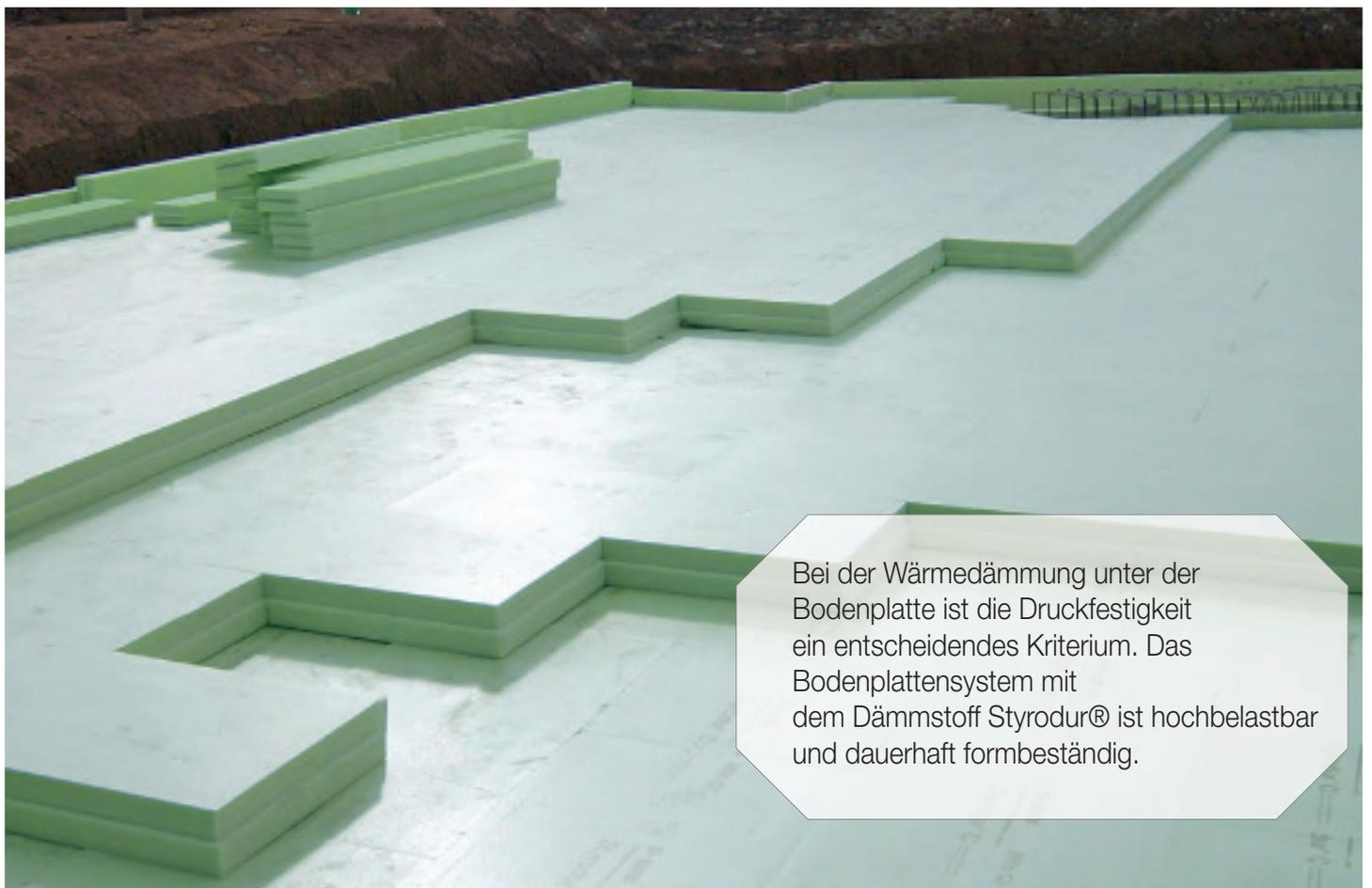
Bei der Wärmedämmung unter der Bodenplatte ist die Druckfestigkeit ein entscheidendes Kriterium. Das Bodenplattensystem mit dem Dämmstoff Styrodur® ist hochbelastbar und dauerhaft formbeständig.
